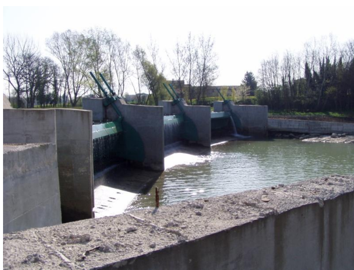
Figura 5: Impianto di Ponte S. Giovanni: l'opera di sbarramento a paratie mobili rotanti
