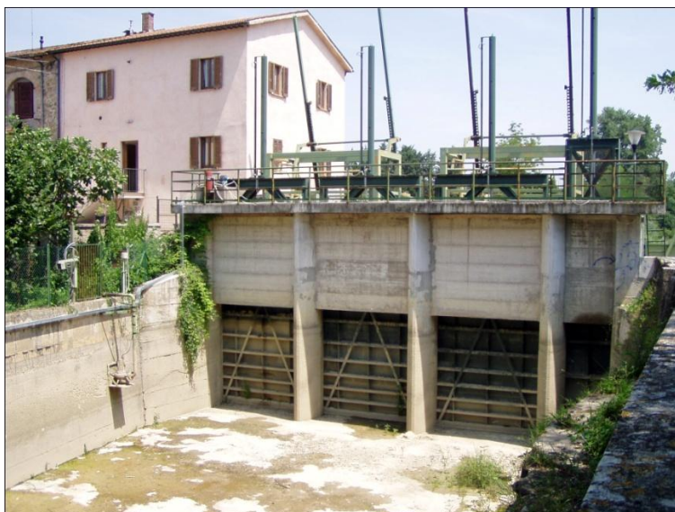
Figura 4: Centrale di Ponte Felcino: dettaglio dello sgrigliatore dell'opera di presa
