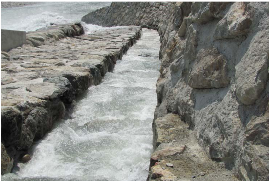
Figura 26: Esempio di scala di risalita in pietrame per l'ittiofauna
